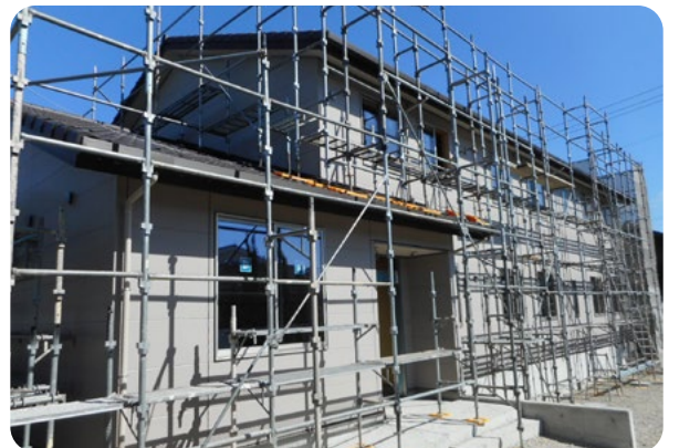
屋根、外壁等ができ上がったグループホームソレイユB
